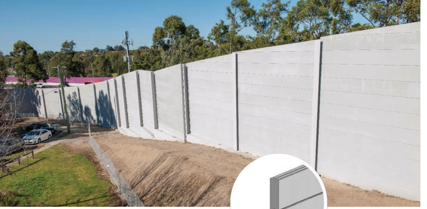
Şekil 3. Ytong panellerin lambazivana profil yapısı
